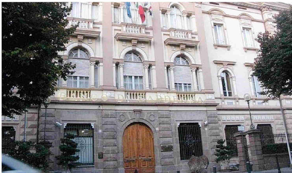
La sede centrale del Banco di Sardegna a Sassari in viale Umberto I
